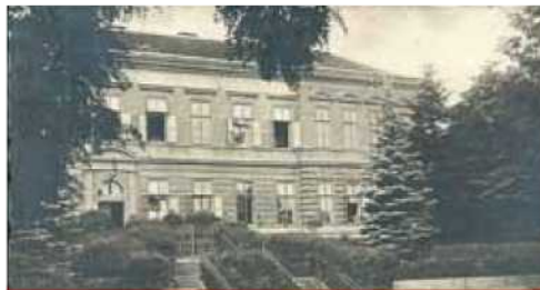
Původní 1. budova nemocnice z roku 1892 vchod z ulice Lidické.
